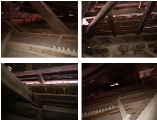
Gambar 22. Foto hasil survey atap Gedung LFM Sumber : Dokumen Lia 25/05/2016
