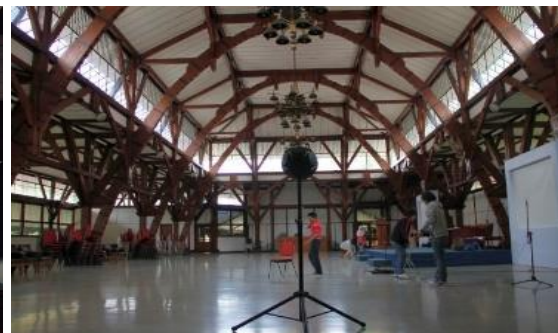
Struktur atap : Wood Frame , utama : arch
